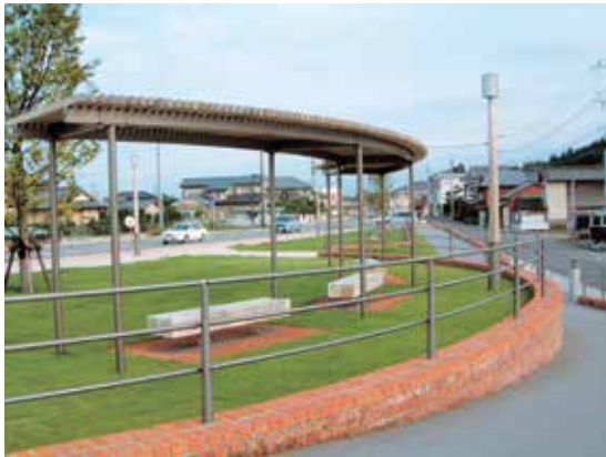
宮崎県 日向市 塩見橋橋詰
