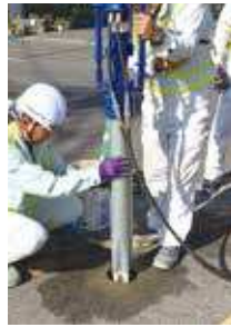
打込機を用いて少しずつ打設
