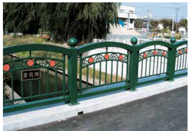
埼玉県 さいたま市中央区 里見橋
