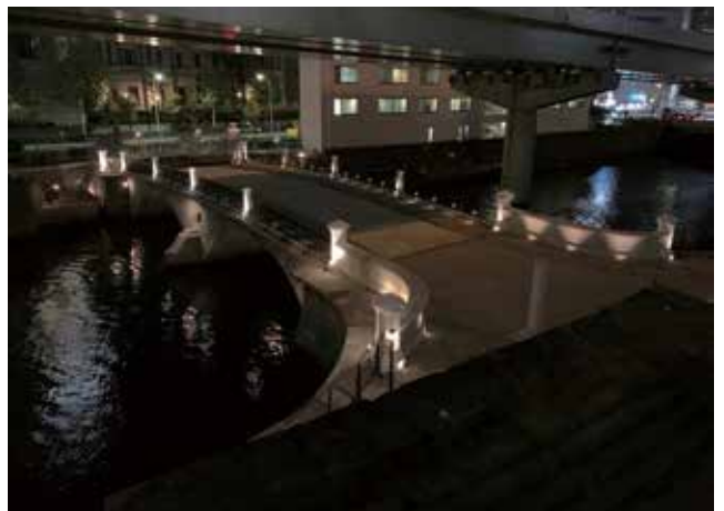
東京都 千代田区 常磐橋
