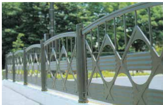
埼玉県 さいたま市南区 一ツ木地下道
