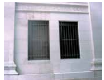
東京都 中央区 三井本館
