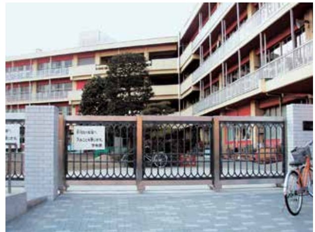
埼玉県 戸田市 戸田南小学校
