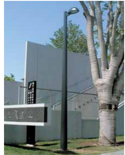
埼玉県 上尾市 埼玉県立武道館
