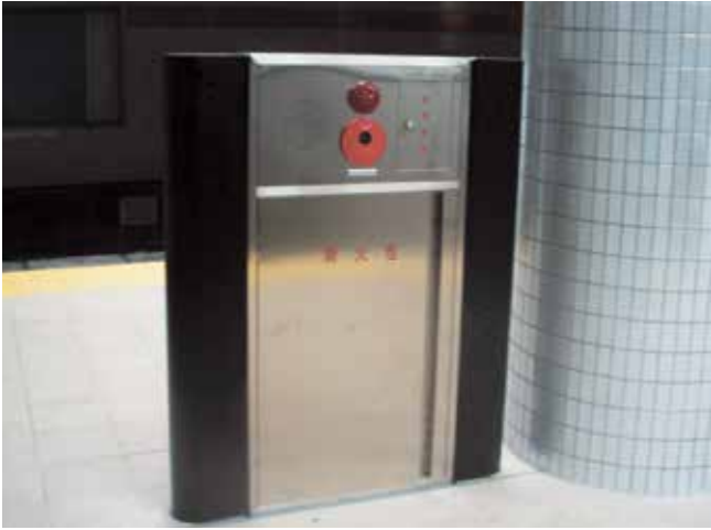
埼玉県 川口市 地下鉄南北線鳩ヶ谷駅
