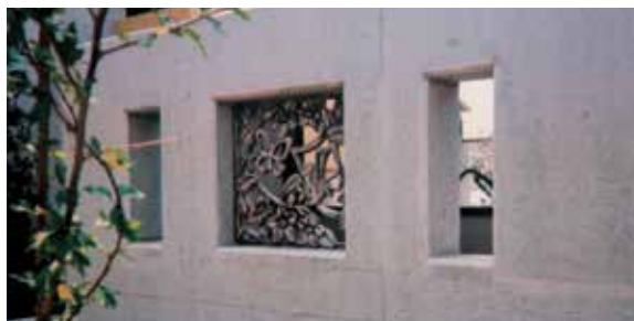
埼玉県 川口市 県営赤山住宅
