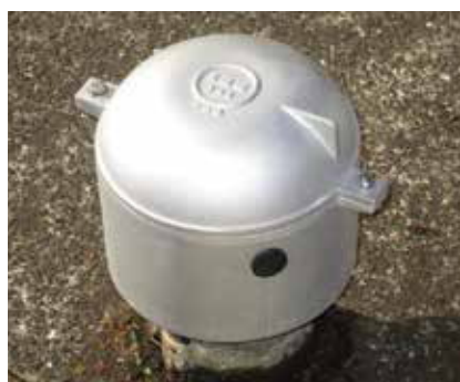
⑧ゴムキャップを取付け完成
