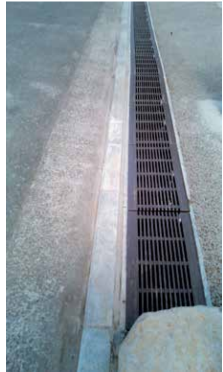
東京都 武蔵野市 境山野公園側溝蓋
