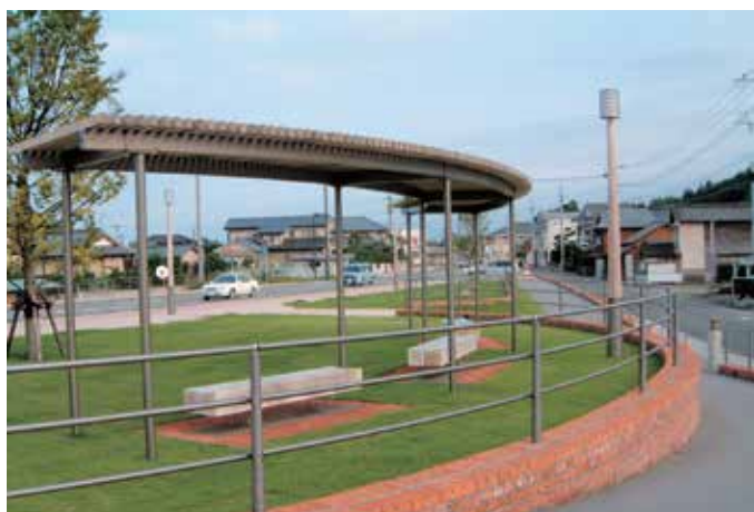
宮崎県 日向市 塩見橋橋詰
