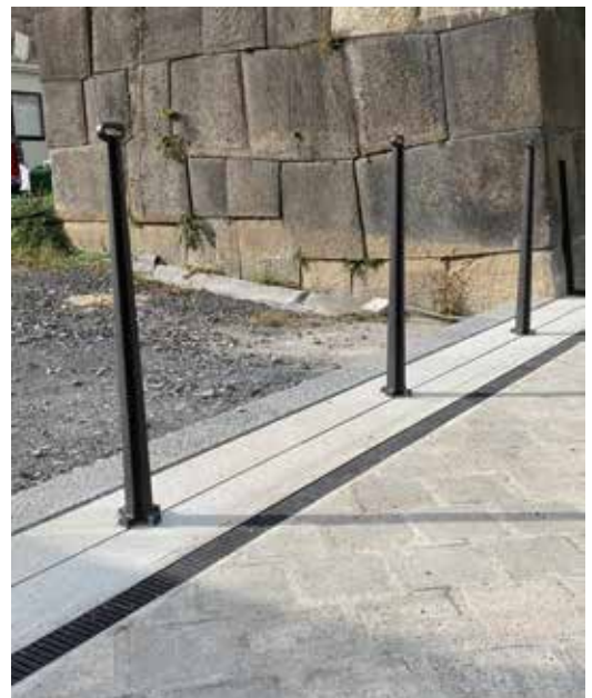
東京都 千代田区 常磐橋
