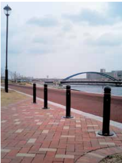
東京都 江東区 スーパー堤防
