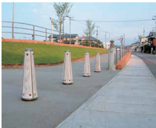
宮崎県 日向市 塩見橋橋詰
