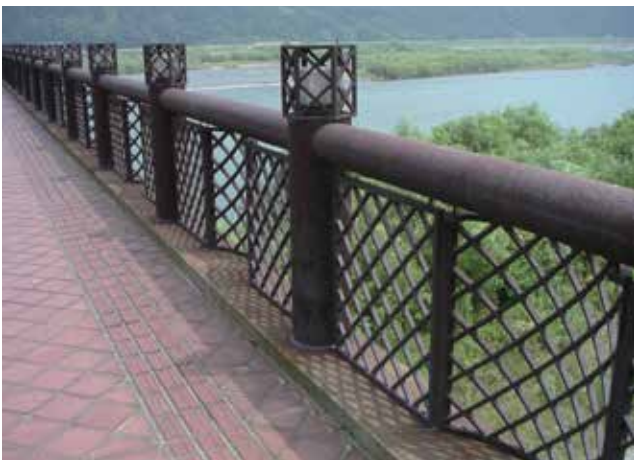
福井県 勝山市 北島鮎大橋
