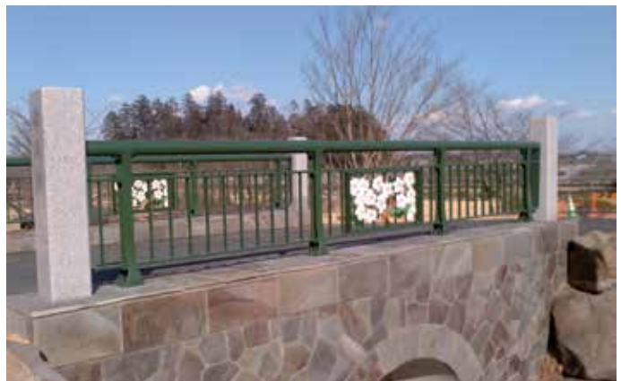
栃木県 栃木市 つがの里 華巖橋
