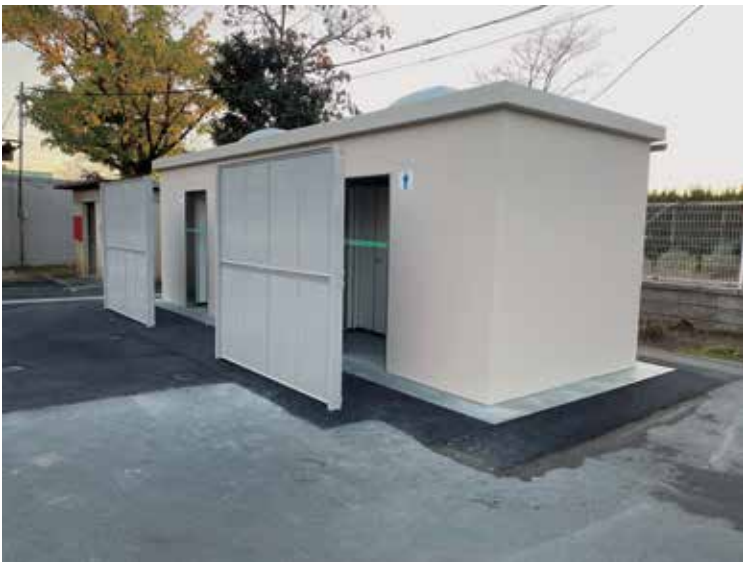
埼玉県 川口市 在家中学校 ユニットトイレ
