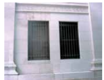
東京都 中央区 三井本館
