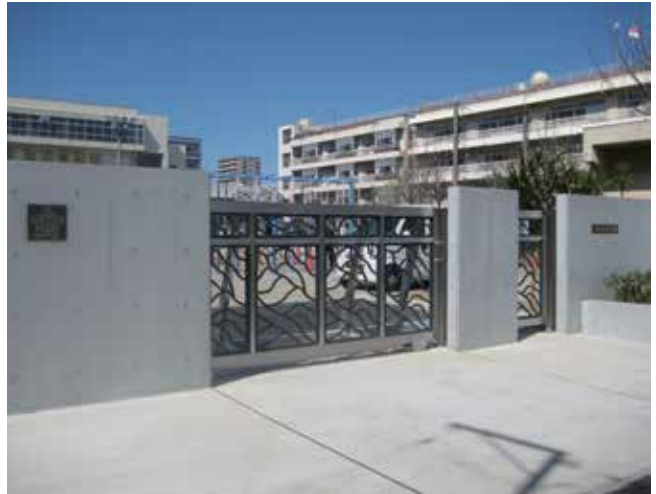
埼玉県 川口市 青木中央小学校
