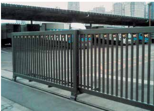
神奈川県 横浜市神奈川区 横浜中央卸売市場
