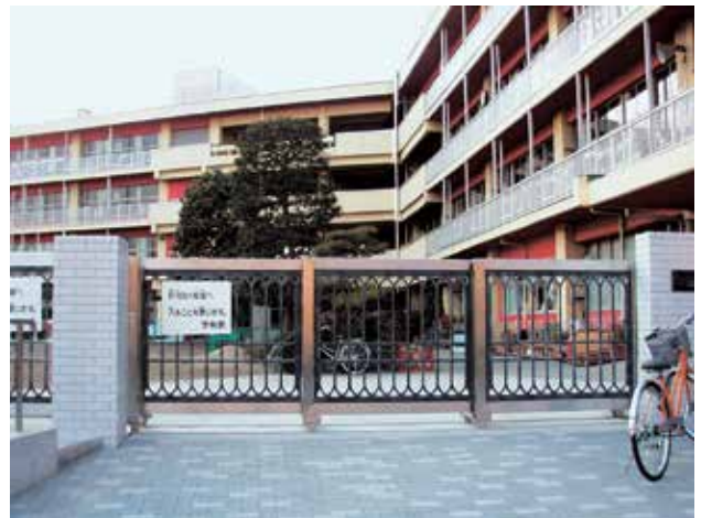
埼玉県 戸田市 戸田南小学校
