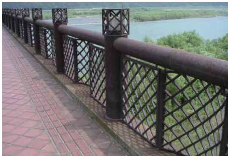
福井県 勝山市 北島鮎大橋
