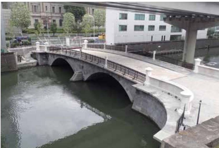
東京都 千代田区 常磐橋
