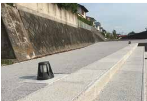
埼玉県 鴻巣市 武蔵水路
