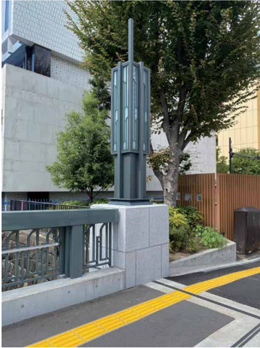
東京都 文京区 後楽橋親柱（鋳物部）
