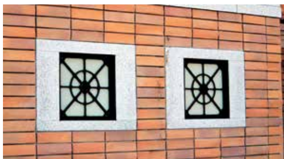
神奈川県 横浜市中区 山下公園トイレ面格子
