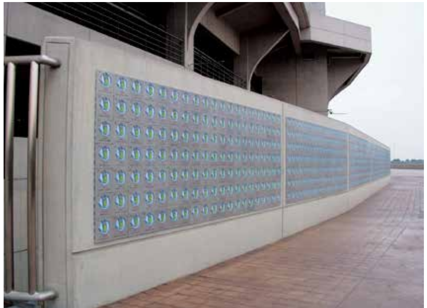
埼玉県 さいたま市緑区 埼玉スタジアム
