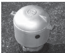
⑧ゴムキャップを取付け完成
