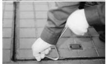
②三角形の角部を支点としてフック部を保持している手で上下させ、手前に引きながらすき間の砂、泥などを外に出しながら進め、周囲の1/2~2/3進んだらふたを開けてください。角型の場合は、周囲2辺の堆積物を出してふたを開けてください。
