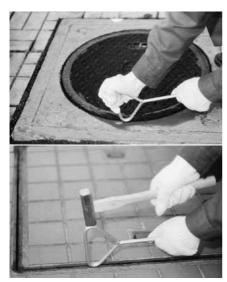
①ふたと枠のすき間に枠の底面までバー部を差し込んでください。堆積物の硬い場合はBMCキー三角形の角をハンマーなどで叩き、よく差し込みます。
